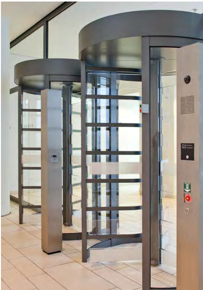
Sicherheitsdrehkreuz für Innenbereich mit Vereinzelung Motiv dormakaba
