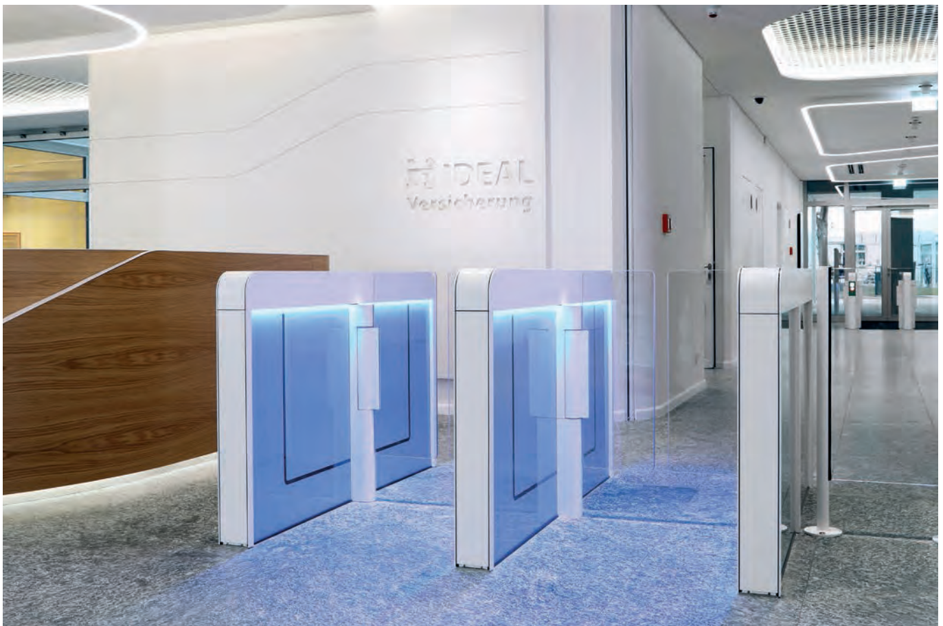
IDEAL Versicherung Hauptsitz Berlin Sensorschleuse mit Fluchtwegfunktion und breitem Durchgang für Menschen mit Behinderung sowie für Transporte
