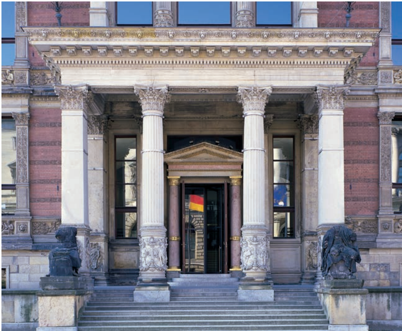
Martin-Gropius-Bau Berlin, dreiflügelige Karusselltür mit Antrieb unter der Kellerdecke, Fluchtwegfunktion
