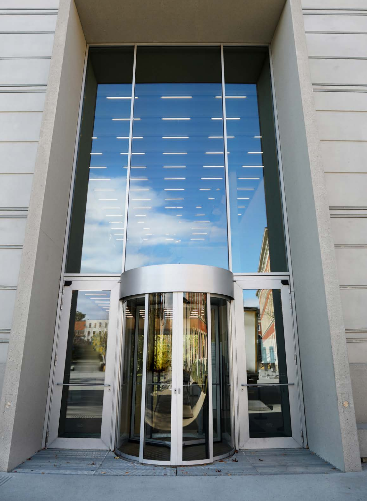
Bauhaus Museum Weimar dreiflügelige Karusselltür mit Antrieb im Fußbodenbereich. Sonderhöhe 3,90 m.
