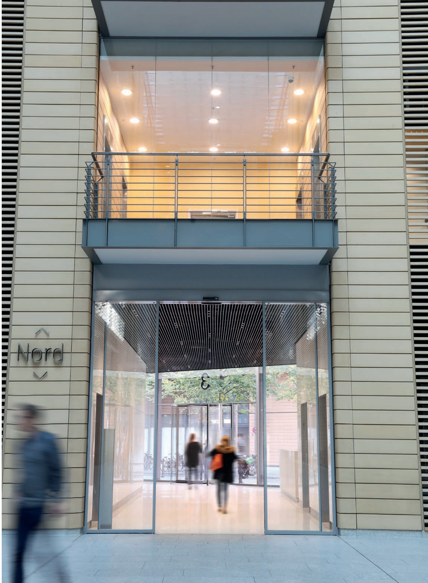
Bürohaus C1 Berlin Potsdamer Platz, automatische Schiebetüranlage, 4.000 mm Durchgangshöhe
