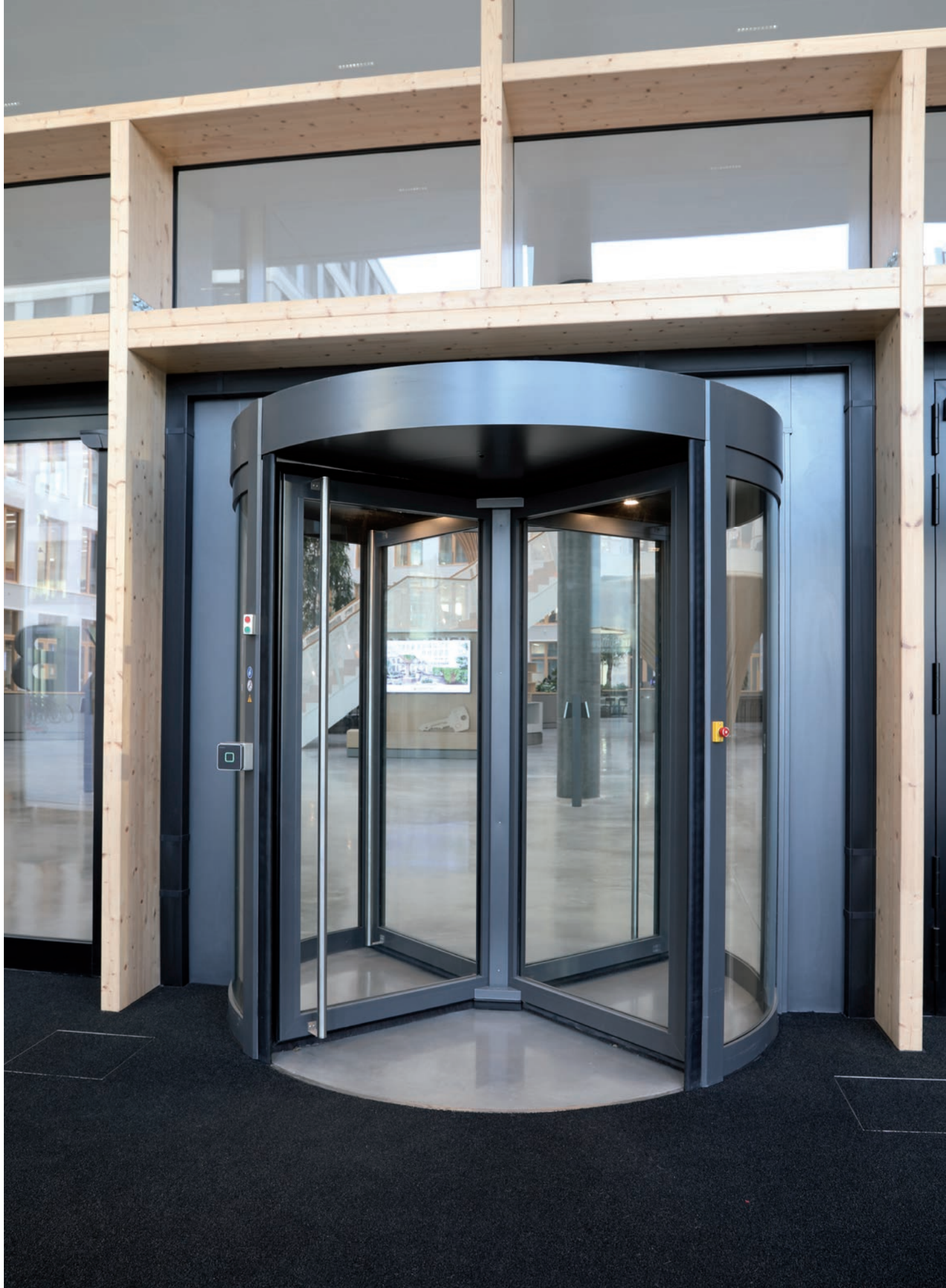
Vattenfall Deutschland-Zentrale Berlin Sicherheitskarusselltür mit kontrolliertem Zugang über Kartenleser
