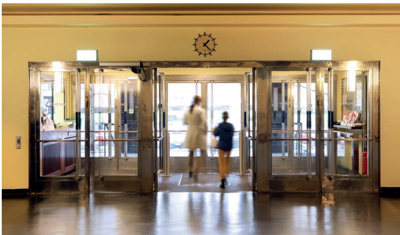
rbb Haus des Rundfunks, Berlin Projektierung und Installation der Vereinzelungsanlage im denkmalgeschützten Windfang-Bereich
