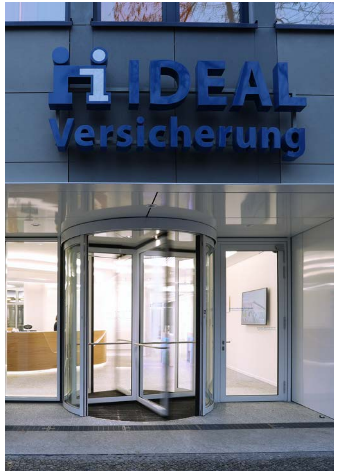
IDEAL Versicherung Berlin: Sicherheitskarusselltür, RC2 sowie Nebentür als Fluchtweg-, Transport- und Behindertendurchgang
