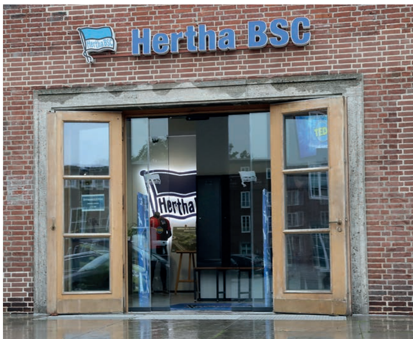
Fanshop Hertha BSC, Berlin automatische Türanlage als Windfang hinter historischer Holzeingangstür
